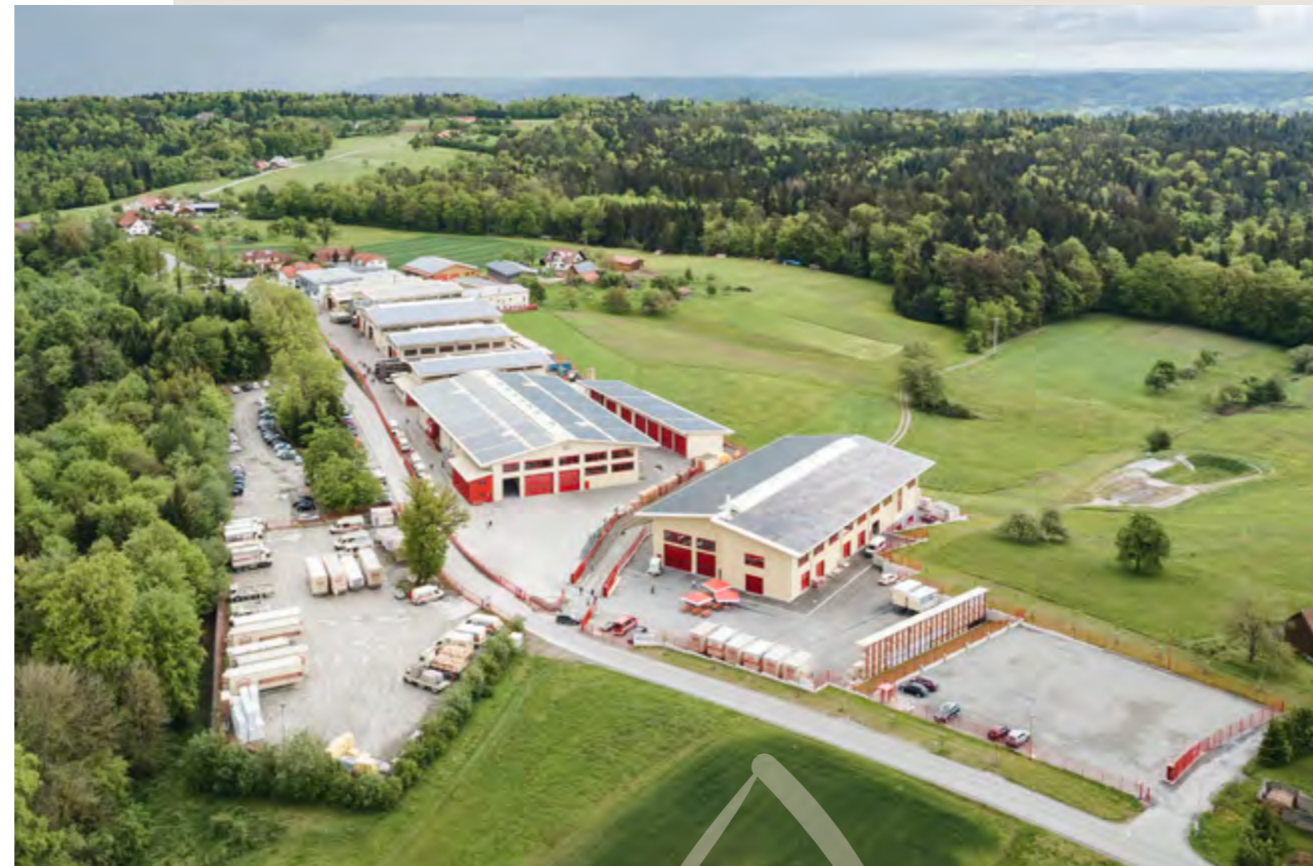
Das Rückhaltebecken mit Retentionsbodenfilter dient der Zwischenspeicherung von Niederschlagswasser und reinigt das Wasser auf natürliche Weise.
