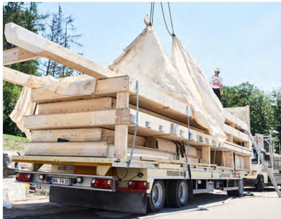
Diesel-Lkw beim Hausaufbau – für den Materialtransport nutzen wir einen eigenen Fuhrpark, anstatt Speditionen zu beauftragen.
